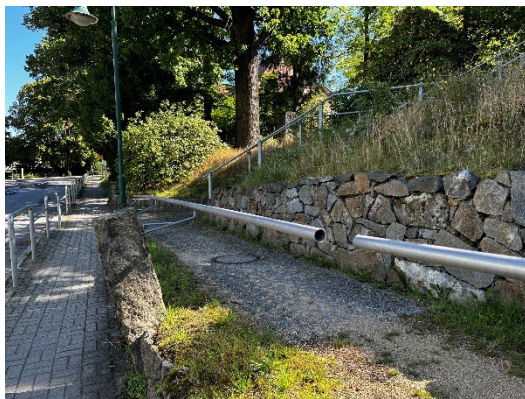
„Braubweg“ mit Bestandsmauern (Naturstein)
