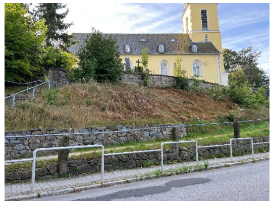
Bestandsmauern am Hang
