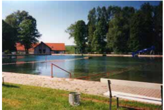
neu gebaut: Funktionsgebäude und Röhrenrutsche
